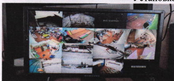
Установка дополнительных видеокамер
