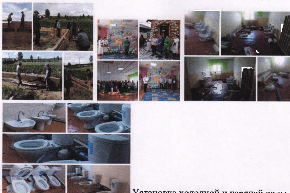
Установка холодной и горячей воды
